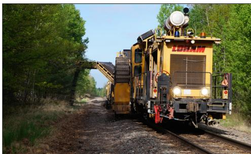
**Descarga de lastro.** A HP SBC distribui o lastro limpo ao longo dos ombros a uma velocidade variável dependendo das condições locais. Além disso, estabelece a inclinação de ombro especificada para a ferrovia à medida que avança.
